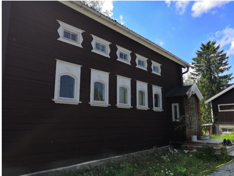
Kuva 5. Kuvassa päärakennuksen julkisivua.
