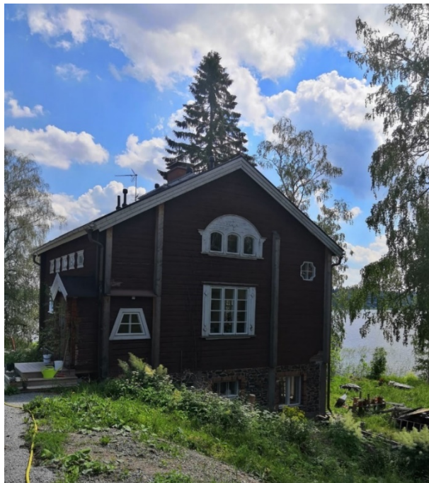
Kuva 8. Päärakennus idän puolelta kuvattuna.
